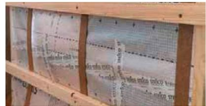
Bei Querverlegung der Bahn empfiehlt es sich die Überlappungsverklebung in der Feldmitte zusätzlich mit STEICO*multi tape* Stücken kreuzweise zu verstärken
