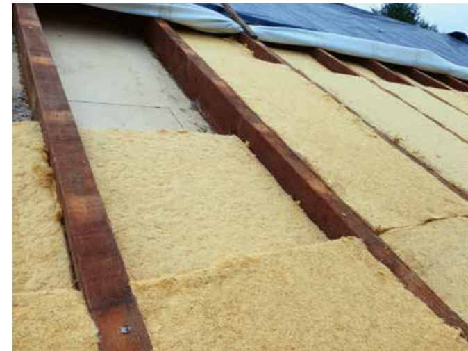
▲ Zwischen die Sparren wurden zwei Lagen Holzfaserdämmstoff eingelegt
