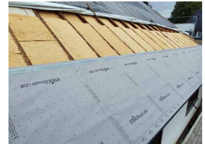
▲ Darüber verlegten die Dachdecker eine passende Luftdichtungsbahn
