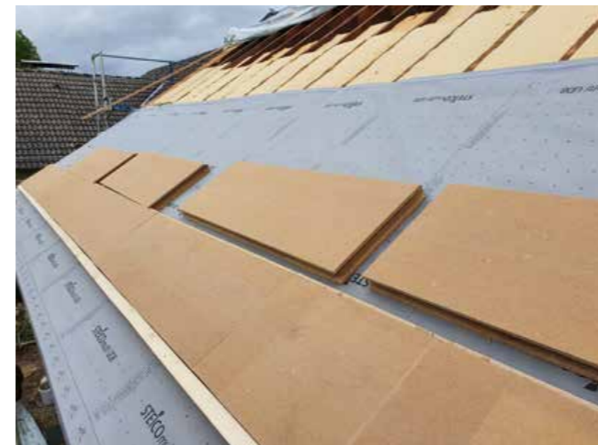
▲ Im nächsten Arbeitsschritt kam eine robuste Unterdeckplatte aufs Dach
