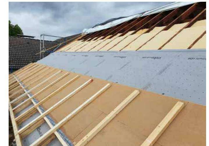
▲ Die hydrophobierten Elemente dienen als zweite wasserführende Schicht
