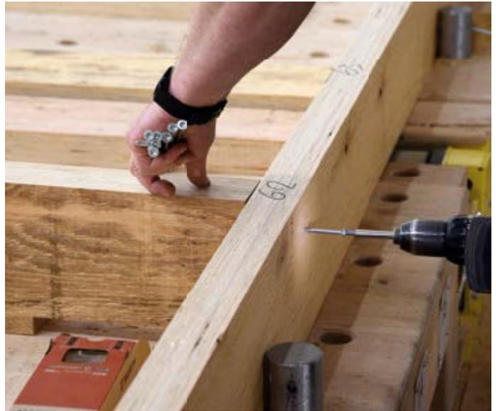
Außenwandelement in Holzrahmenbauweise: Wenn die Querdruckspannung, den die Wandständer bei Schwelle und Rähm erzeugen, für Nadelvollholz zu hoch wird, ist die Ausführung mit Furnierschichtholz die einfachste Lösung.
