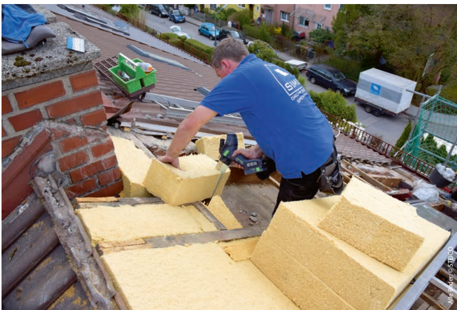
Mit der flexiblen Holzfaser-Dämmmatte STEICOflex 036 werden die Gefache sparrenhoch gefüllt – ohne dass vorher eine Dampfbremsbahn eingebracht wurde.
