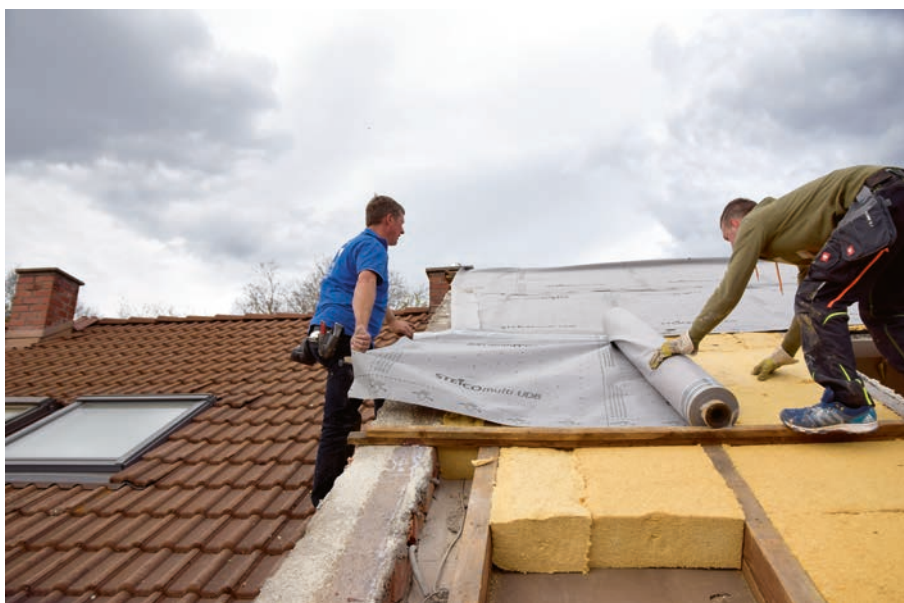
Die Luftdichtungsbahn STEICOmuli UDB schließt die Gefache. Sie lässt sich über der Sparrenebene schnell verlegen und an den Ortsgang anschließen.
