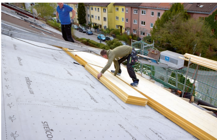
Die robuste Holzfaser-Dämmplatte STEICOspecial dry dient als Unterdeckung, sorgt für den gewünschten U-Wert und verschiebt die Taupunkte nach außen.
