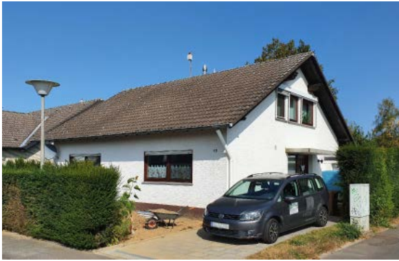
Das Einfamilienhaus vor Beginn der Sanierungsarbeiten Fotos: Steico
