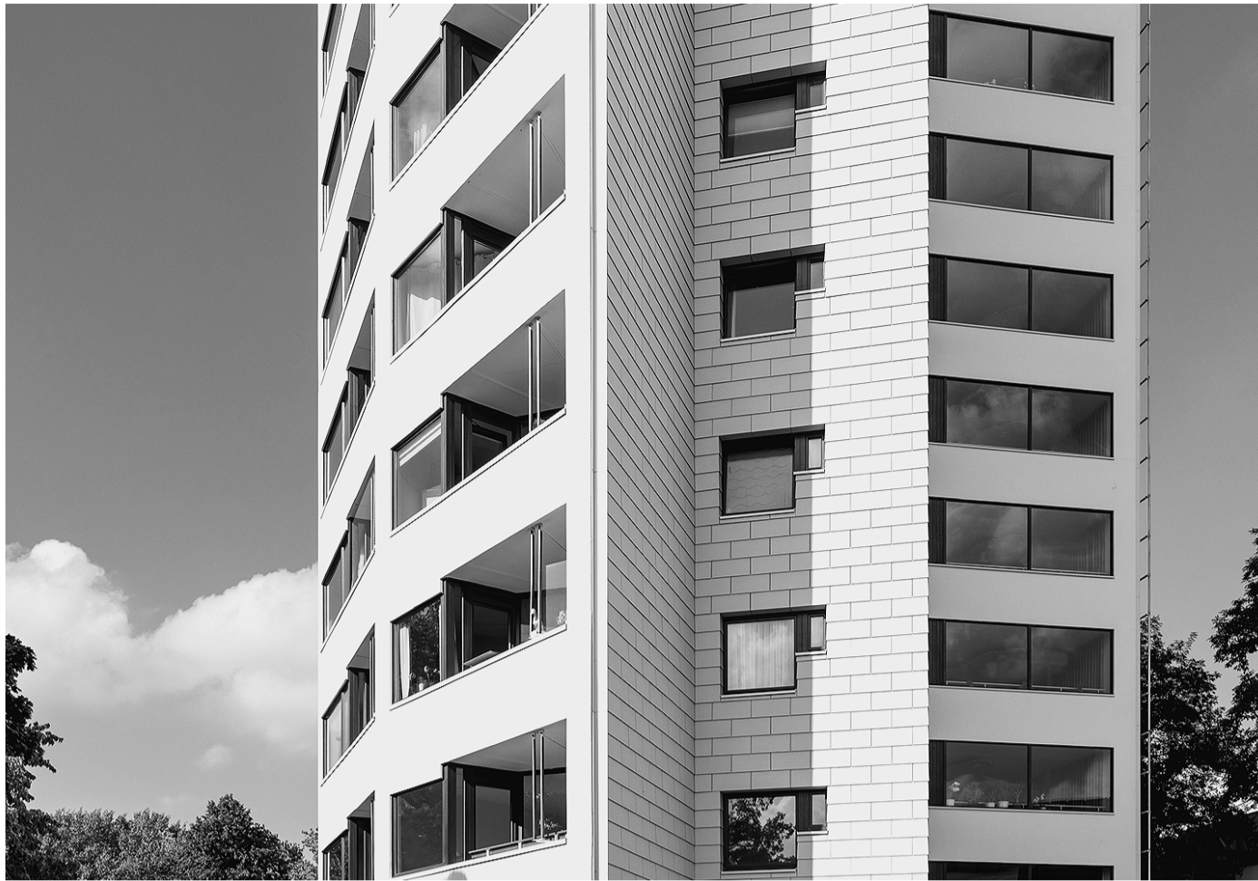
Noch heute überzeugt der Entwurf des Architekten mit seinen modernen Elementen – die Sanierung wurde mit dem Bremer Denkmalpflegepreis 2022 ausgezeichnet. FOTO: DENNIS NEUSCHAEFER-RUBE
