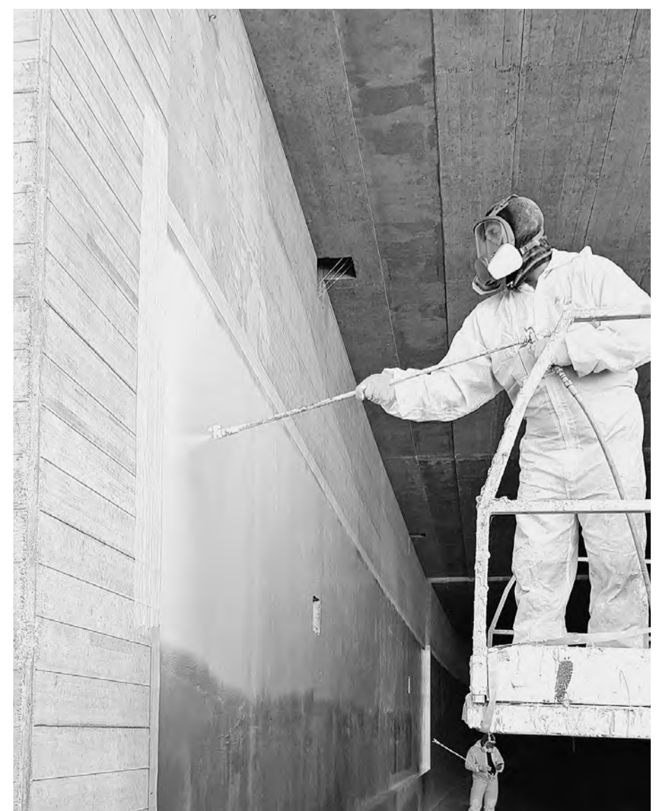
Die 1k-Beschichtung für Verkehrstunnelbauwerke MC-Color T 21 ist sehr widerstandsfähig und langlebig und kann leicht und direkt „aus dem Eimer“ im Roll- und Airless-Spritzverfahren verarbeitet werden. FOTO: MC-BAUCHEMIE
